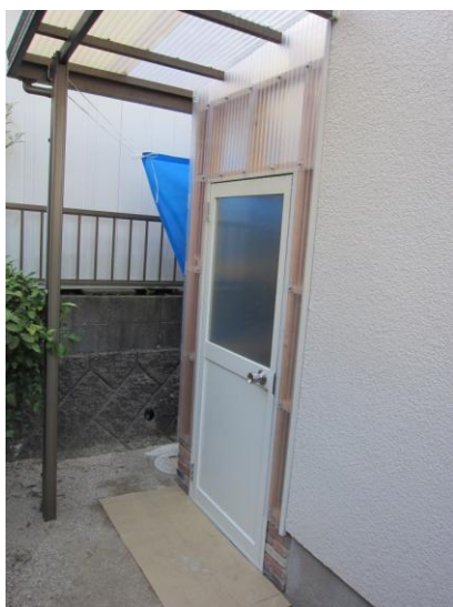
窓のポリカをカットした残りの部分でドアの上を 順次加工して貼っていきます
