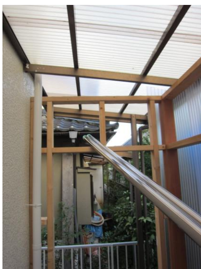
これは室内から外を見た感じです こちら側は窓のところのポリカをカットした残りで貼っていきますので、まだ こちら側はポリカ貼ってありません
