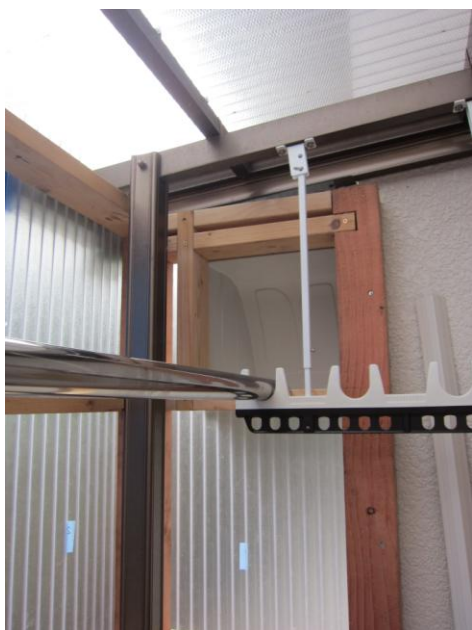
換気扇もポリカをカット フード取り付け
