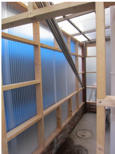
ドアから中を見ている感じです この太い竿は38φ 有ります 何でも洗濯名人に聞く話によると洗濯物の中に風を多く通す方が早く乾くそうです。 まだ室内に合わせていませんので 竿が外に飛び出しています ポリカーボネイト 7 尺 8 枚建具が入る前に仮に取り付けて 窓 カンキセン ドアと囲ってカットする所の確認をしているところです
